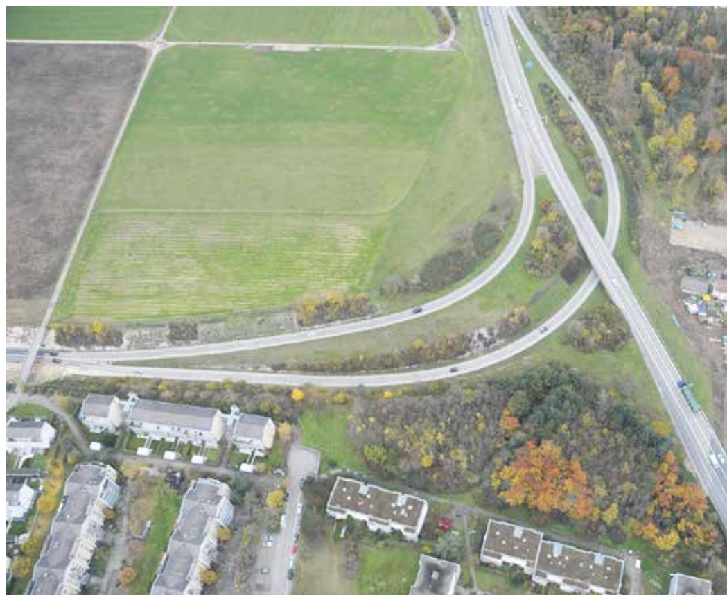
Der Anschluss Aesch (Bild) wird zu einem Vollanschluss ausgebaut.
