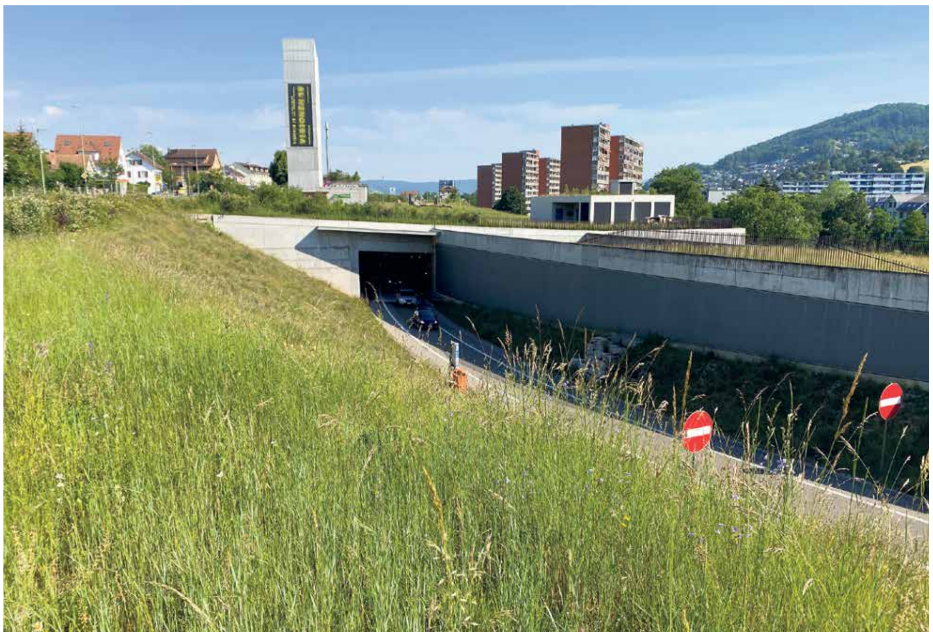
Die N22 ist ein Beispiel intelligenter Strassenführung und schafft gleichzeitig nutzbare Fläche.
